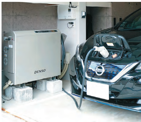
EV専用パワーコンディショナの導入で、我が家の車が発電所に。
